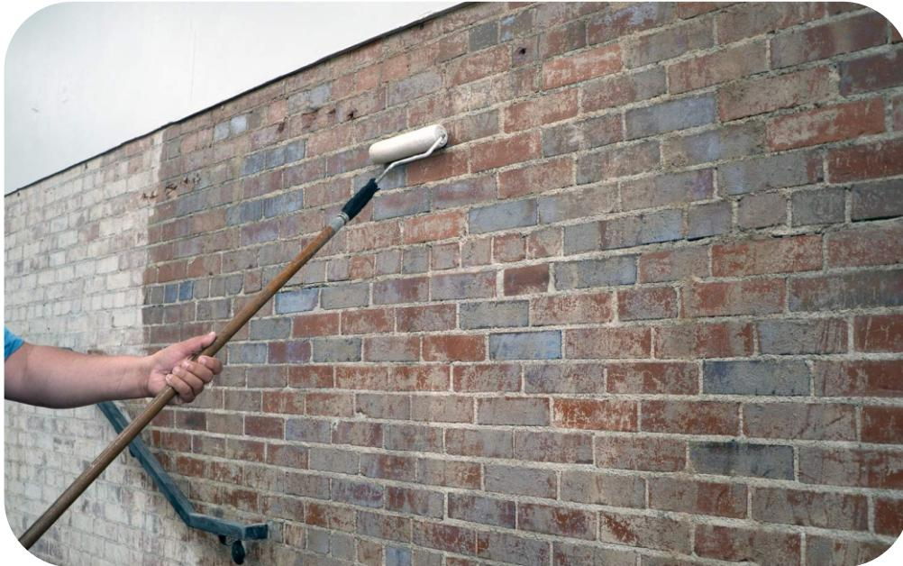
لاکهای پلی اورتان با مقاومت خش پذیری بسیار بالا و نفوذ ناپذیری کامل در برابر آب و مشتقات نفتی به منظور پوشش دهی و محافظت از سطوح بتونی و سنگی کف فضاهای عمومی ، پارکینگ ها و در برخی موارد به منظور تقویت ناماها به منظور ایجاد یک لایه یکپارچه و جلوگیری کننده از جدایش قطعات از نما استفاده می گردد .
