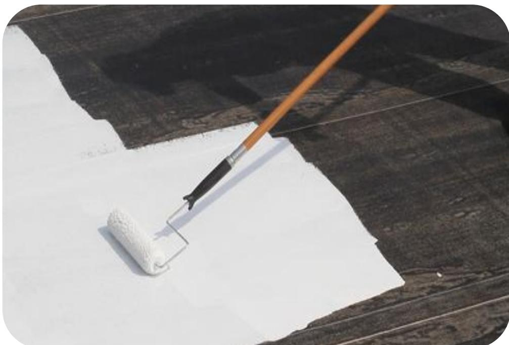
با توجه به کیفیت سطحی بستر عایق و در صورت وجود ریزترک و یا حفرات ریز میتوان از این محصول جهت ترمیم و اصلاح زیرکار و بستر جهت عایقکاری و اصلاح آن استفاده نمود .
