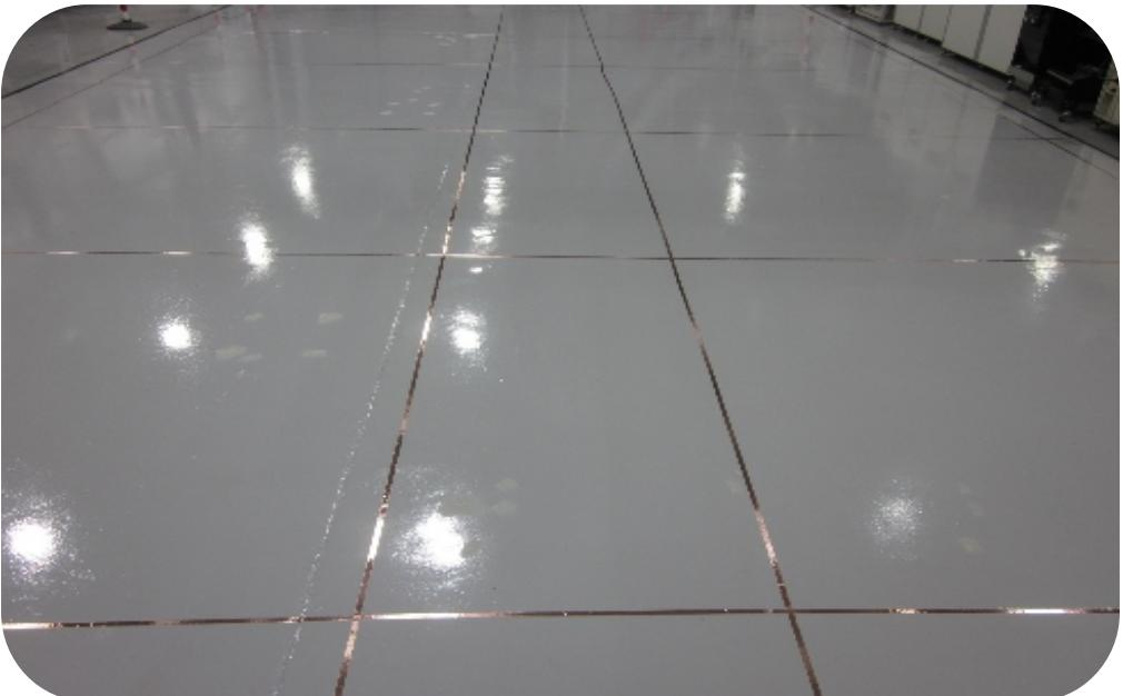
فعالیت‌هایی چون راه رفتن روی کفپوش و یا تماس لایه‌های لباس با هم در زمان حرکت قادر به تولید هزار ولت است. این بار الکتریکی بوجود آمده در صورتی که به نحوی از محیط خارج نشود می‌تواند عامل ایجاد جرقه شود. این جرقه یا تخلیه الکتریکی می‌تواند در برخی از کاربری‌های مانند اتاق سرور، اتاق عمل و انبار مواد منفجره خطرآفرین باشد.
