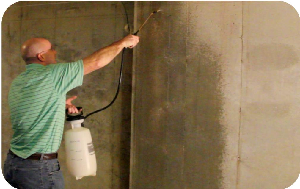
از پنترن مایع میتوان بعنوان جدیدترین و مقرون به صرفه ترین محصول در زمینه شیمی ساختمان با استفاده از نانو تکنولوژی نام برد . از موارد کاربرد آن می توان بعنوان محافظ و کیورینگ بتن های تازه بر روی سطح آنها استفاده کرده تا از تبخیر سریع آب بتن جلوگیری شده و با کاهش چشمگیر سرعت تبخیر آب ، موجبات هیدراتاسیون کامل تر سیمان و رسیدن به مشخصات مکانیکی بهتر و حذف ترک خوردگیهای ناشی از انقباض ملات را بوجود آورد .
