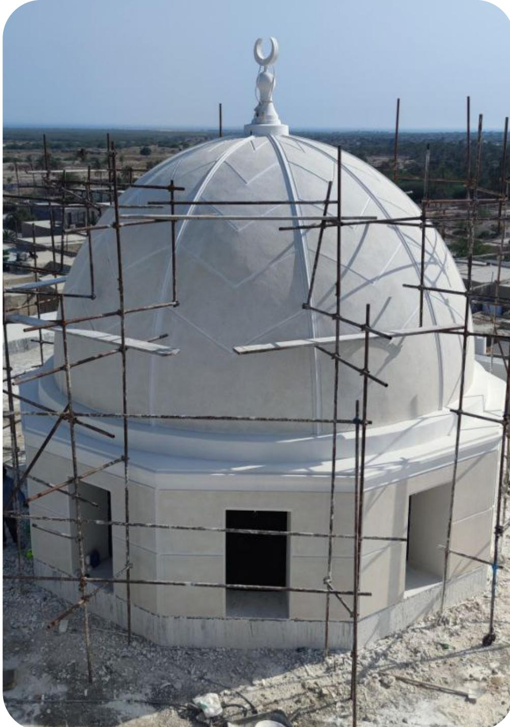
پوشنگ پایه سیمانی حاوی پودرهای میکرونیزه ، الیاف و افزودنیهای پلیمری جهت ایجاد خاصیت انعطاف پذیری و جلوگیری از ترک خودگی ، افزایش چسبندگی به کلیه سطوح بستر ، کاربیزیری و بالا بردن دوام و مقاومت آن در مقابل عوامل جوی ، نورخورشید و نیز ضد آب بودن پوشش ایجاد شده می باشد.
