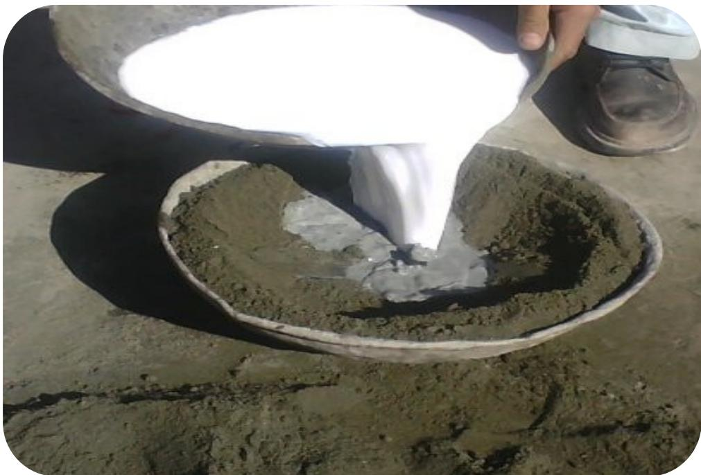
به منظور افزایش میزان چسبندگی ملاتهای سیمانی اعم از زبره و یا نرمه کاری با ملاتهای سیمانی و با هدف ایجاد خاصیت انعطاف پذیری و جلوگیری از ترک خودگی آنها ، اتصال ملاتها و یا بتن جدید به بسترهای قدیمی ، ترمیم درز و ترکها و ... با استفاده از افزودنی ملات حاوی رزینهای کوپلیمر رابر اکریلاتی تولید این شرکت میتوان به سطوحی با کیفیت بالا و با دوام بسیار طولانی دست یافت . ایجاد خاصیت آبیندی دائمی و چسبندگی بسیار بالا از خواص قابل ذکر این محصول می باشد .
