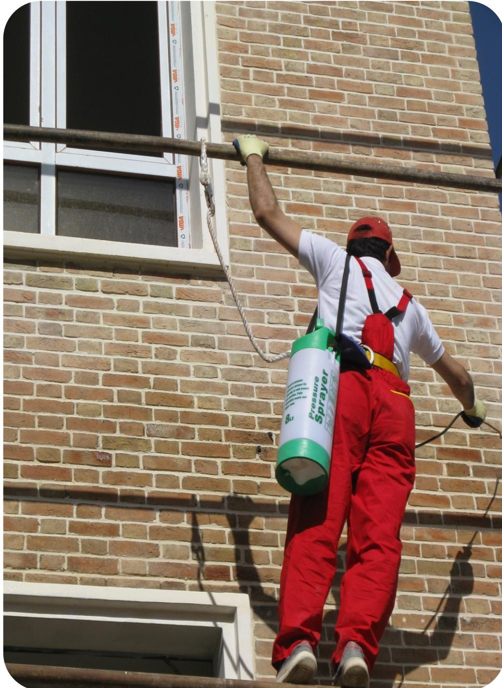
این محصولات مایع نانویی شفاف ، بی رنگ و بو ، آب پایه و غیر قابل اشتعال بوده که پس از اعمال بر روی سطوح ، به عمق لایه ها و بافت سطح نفوذ کرده و علاوه بر حفظ خاصیت تنفس و حذف نم و رطوبت موجود ، با آهک آزاد سولفاتها و ... واکنش داده و تشکیل جرمهای سخت و شفاف سیلیکاتی در داخل منافذ و بافت مصالح داده و آنها را مسدود می نماید .
